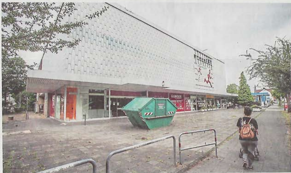
Der Abbruch kann beginnen: Das Sozialkaufhaus unten ist so gut wie leer, der Sportpalast oben zieht in einen Neubau. Fotos: Ralf Krieger
